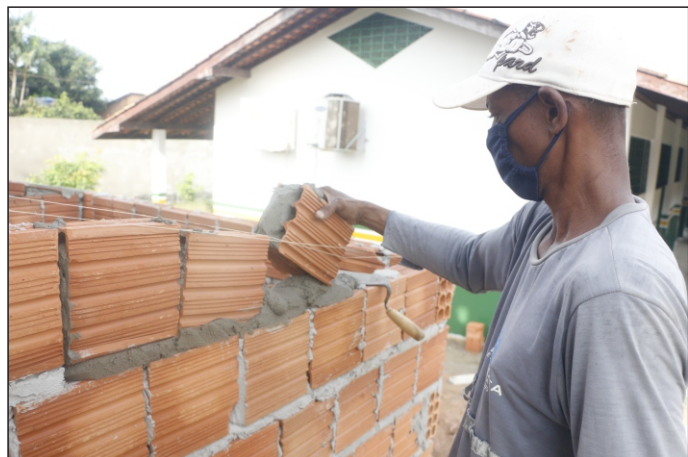
Escola está recebendo ampliação dos muros
