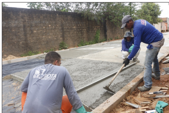
Três ruas estão sendo contempladas com a pavimentação em concreto
