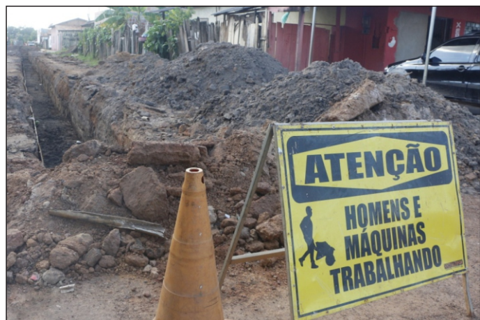
Rua Piauí está recebendo serviço de drenagem
