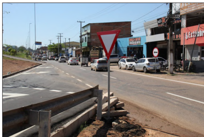
Espaço recebeu nova sinalização para orientar motoristas
