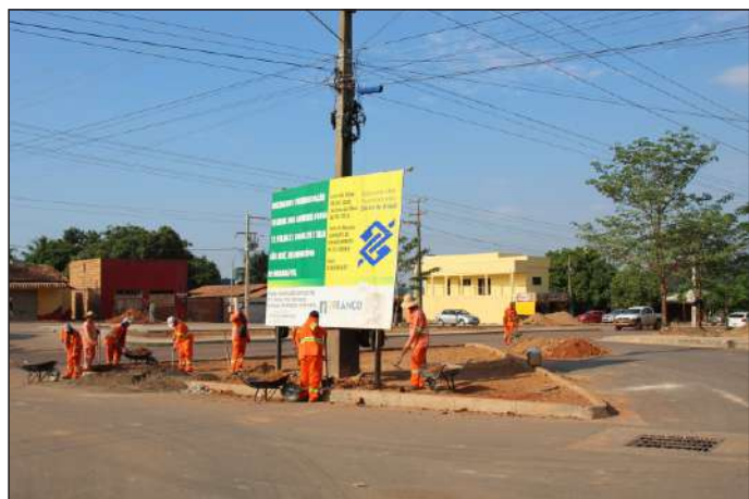
Obras modificaram o trajeto e melhoraram o trânsito na vila
