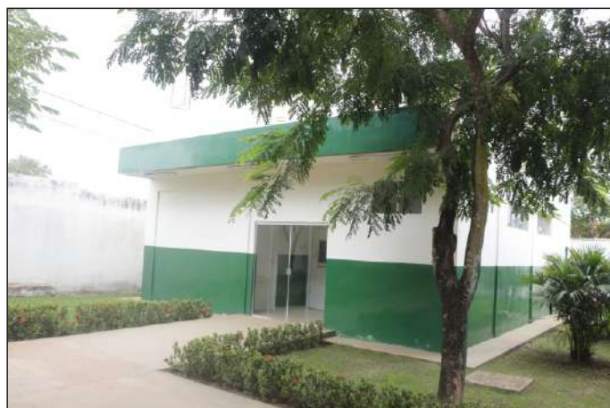
Novo prédio já está finalizado
