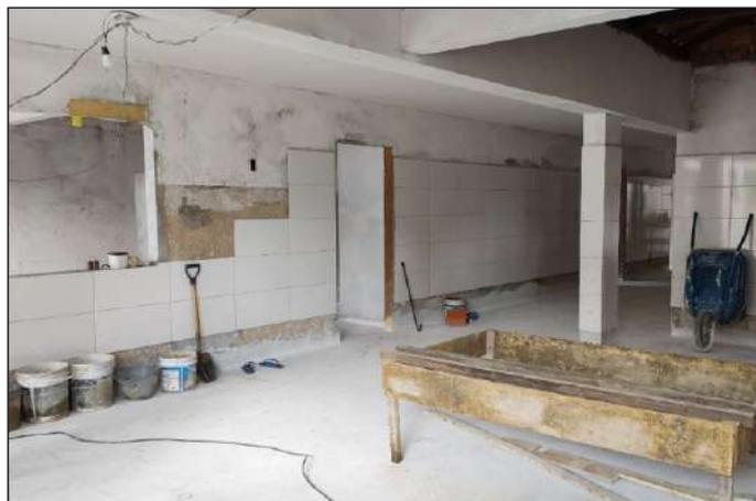
Nesta semana foi iniciado o revestimento das paredes, trocas das partes hidráulicas e elétrica.
