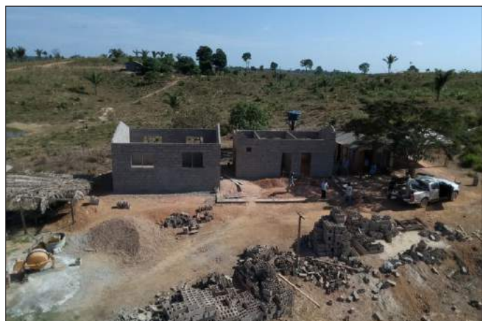
Início das obras da Escola Raio de Sol
