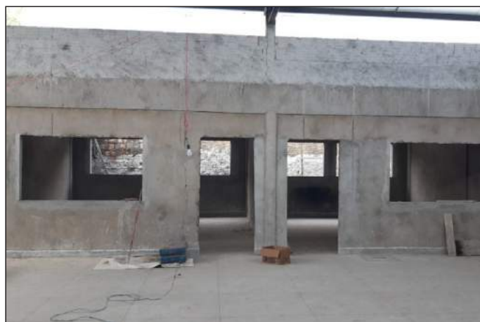
Novo NEI está sendo construído na Rua 5 de Abril.
