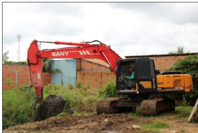
Máquinas também estão atuando na limpeza de grotas e valas.
