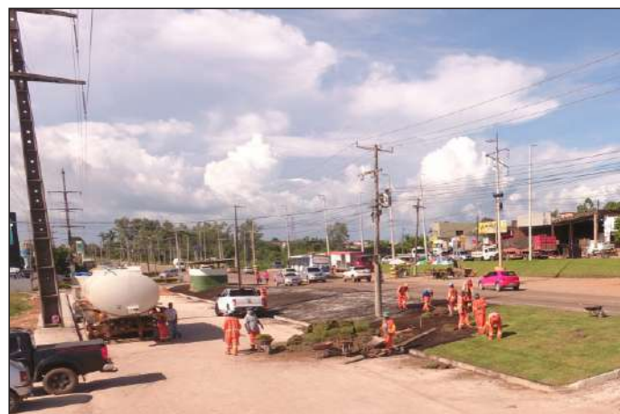
Vias da região receberam serviço de pavimentação no ano passado.
