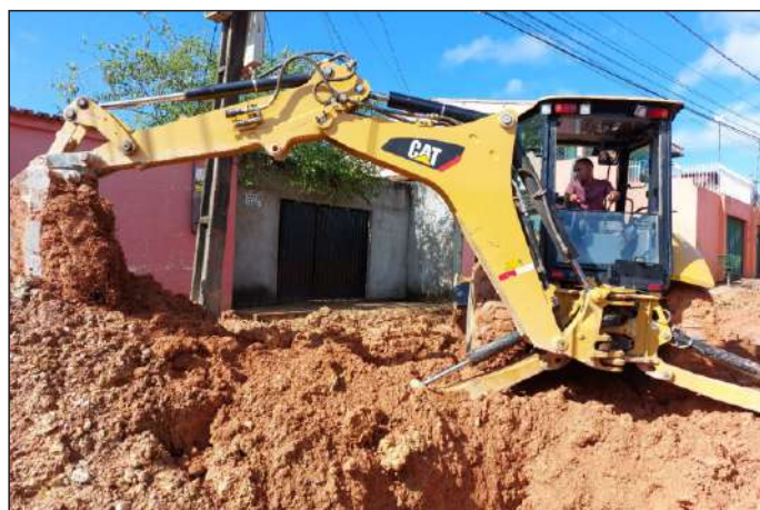
Folha 6 também recebe início das obras de pavimentação
