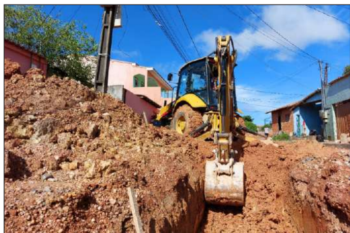
Máquinas já trabalham na drenagem profunda na Folha 28
