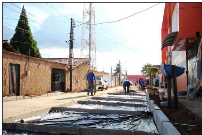
Locais recebem base de concreto por serem mais resistentes
