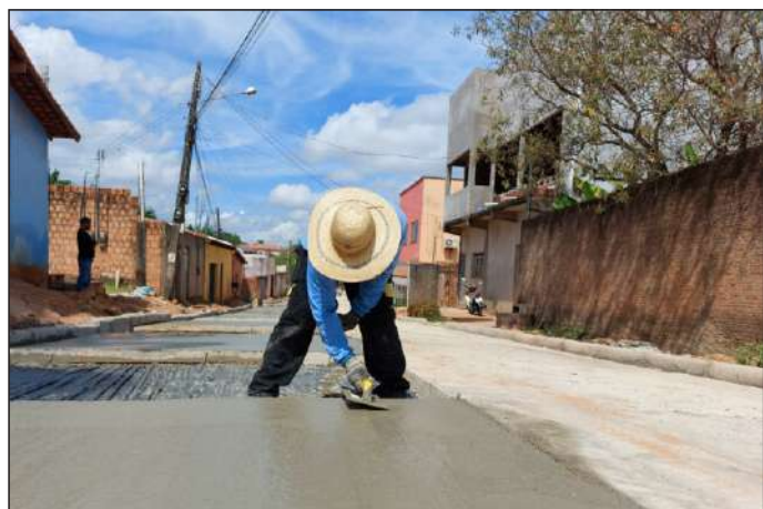
Quadras 6 e 15 já estão em fase de concretagem
