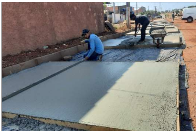
Local já passou por drenagem e terraplanagem.
