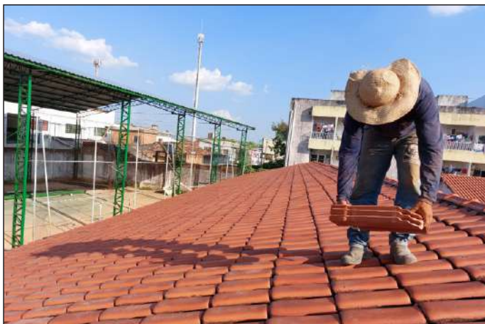
Revitalização das salas foi concluída e trabalhos concentram-se no forro e telhado
