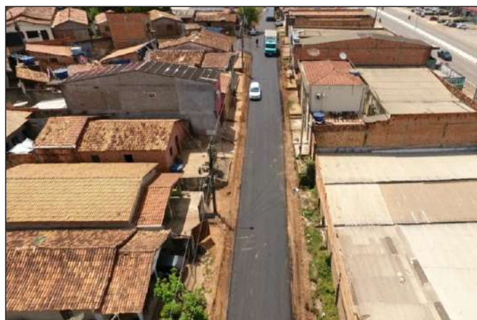
Serviço de infraestrutura abarca toda a Folha 34
