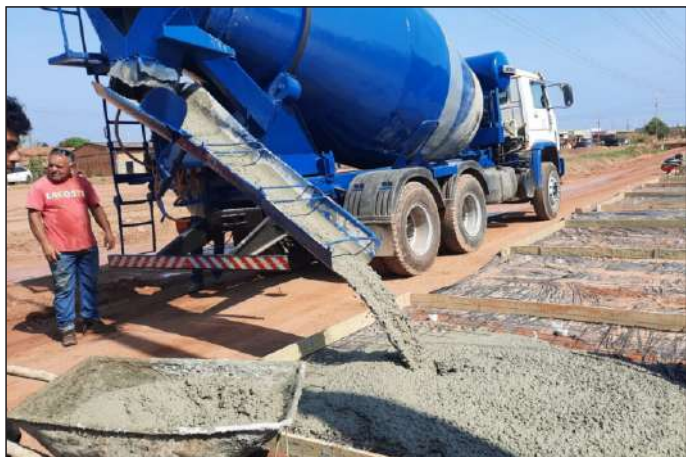
Concreto terá espessura de 12 centímetros para maior resistência
