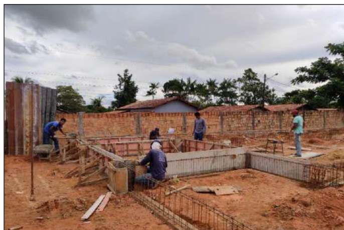
Escola também ganhará quadra poliesportiva, novo refeitório, despensa e área de serviço
