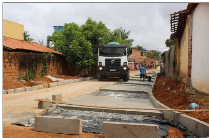
Placas de pavimento rígido têm espessura de 12 centímetros
