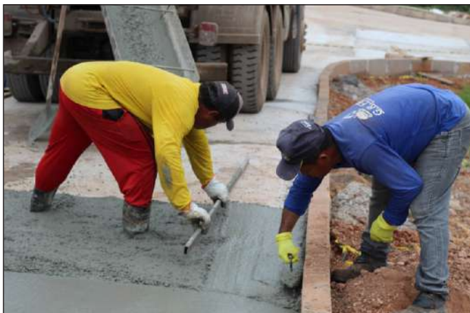
Pavimentação em concreto oferece maior resistência
