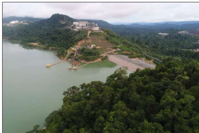
Drones foram utilizados para verificação de imagens aéreas
