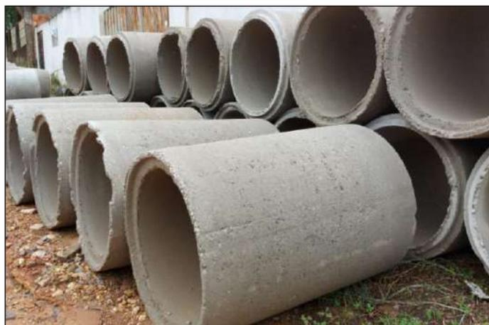
Em instalação, manilhas de caixas de concreto para escoamento da água
