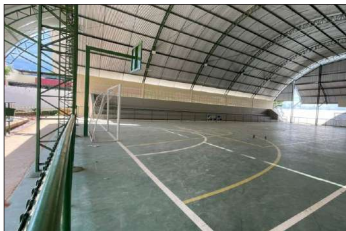
Nova quadra coberta já está sendo utilizada
