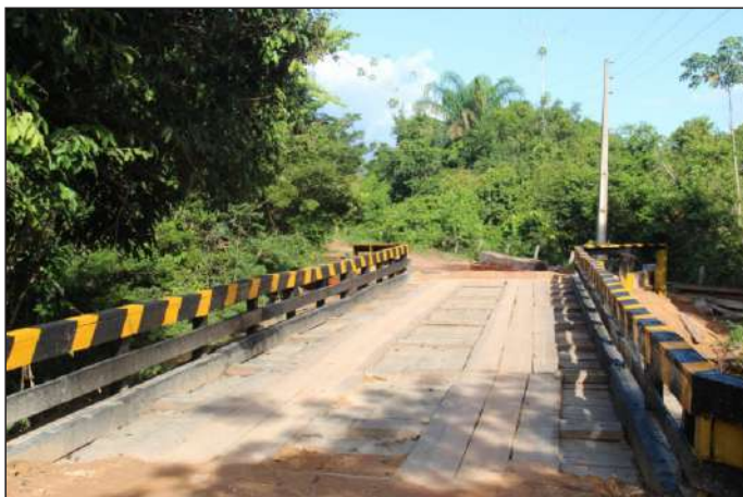
Ponte que liga Murumuru a Vila do Deserto já foi construída
