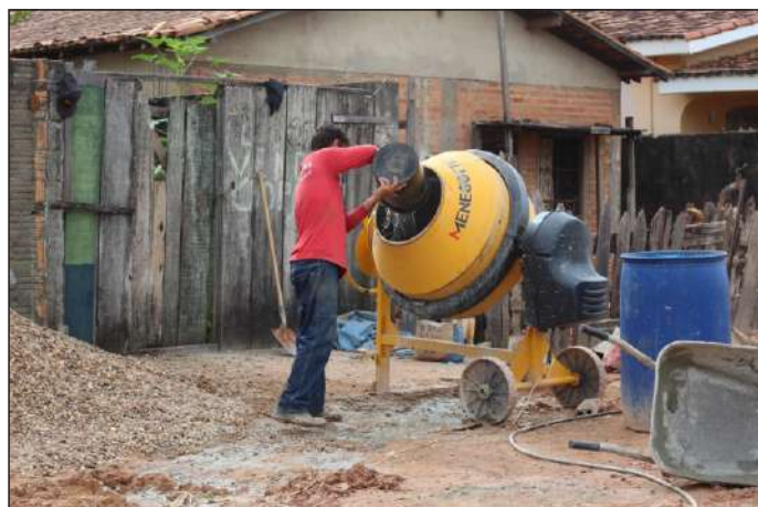
Trabalhadores estão implantando ramais para os bueiros
