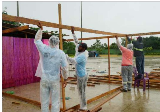
Além da montagem dos abrigos, equipes também trabalham na limpeza dos locais
