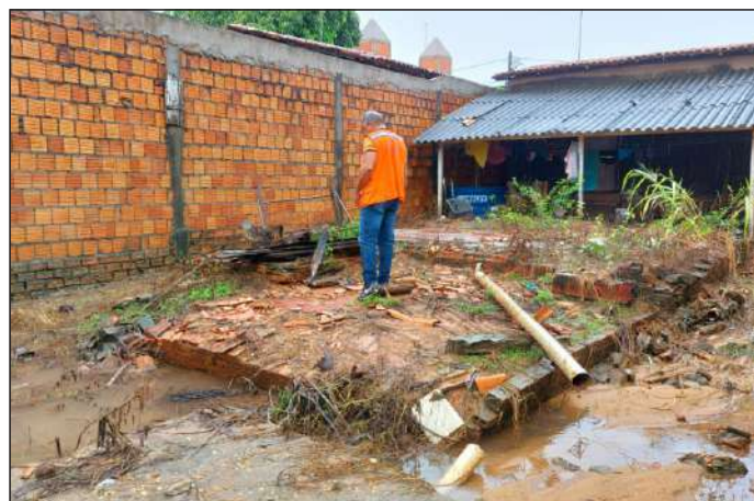
Defesa Civil tem vistoriado locais com maior risco
