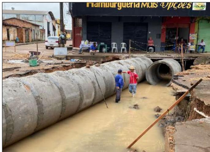
Foram colocadas manilhas de 1500mm em substituição às antigas de 1000mm
