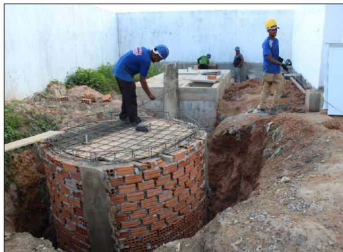
Nova escola passará a contar com acessibilidade
