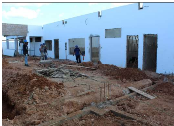
Prédio passará a contar com sete salas de aula
