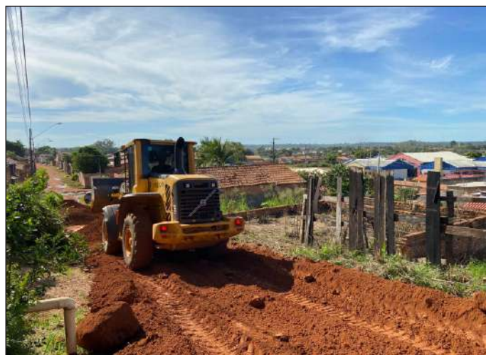
Foi realizado trabalho de nivelamento das pistas utilizando 10 caçambas com aterro
