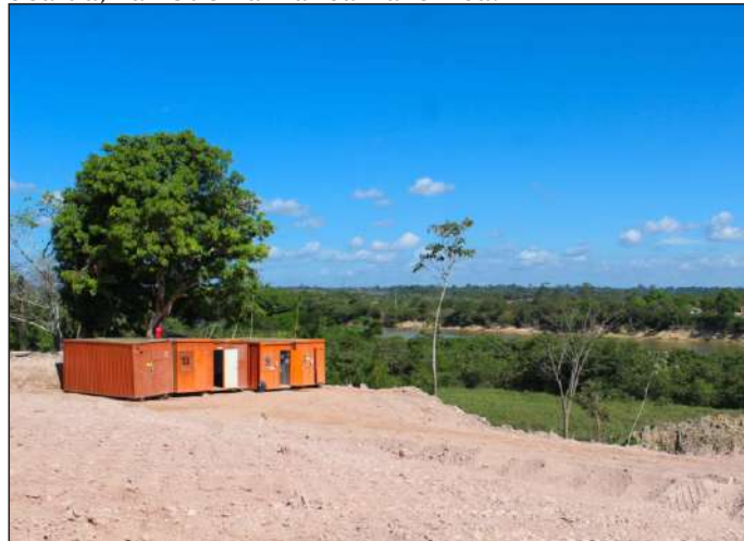
Empresa está implantando a estrutura do canteiro de obras
