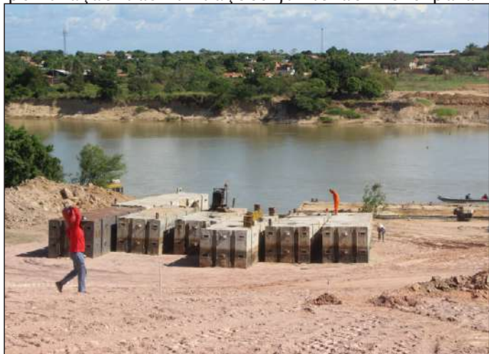
Estacas de fundação serão colocadas por duas equipes, uma na área de dentro do rio e outra na parte de fora
