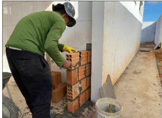
Estrutura está sendo finalizada e em seguida terá início a colocação do piso
