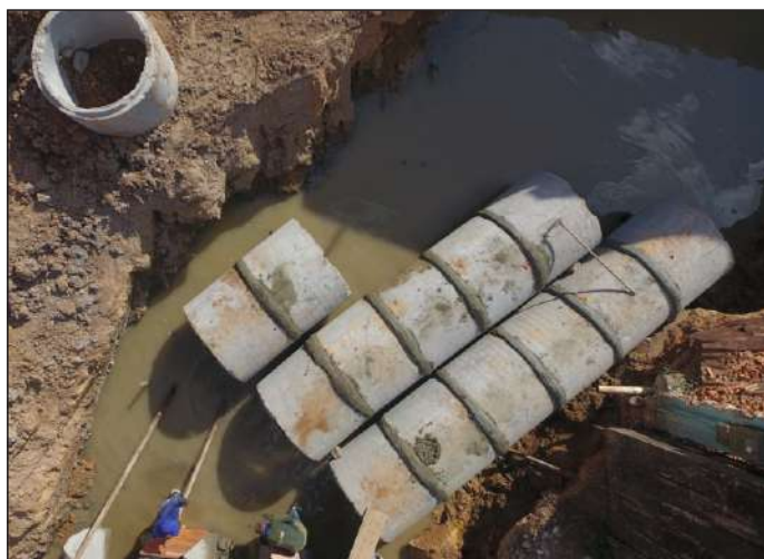
Manilhas foram trocadas por novas com maior vazão
