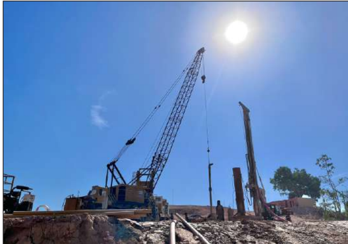
Ponte terá 524 metros de comprimento com 12 de largura
