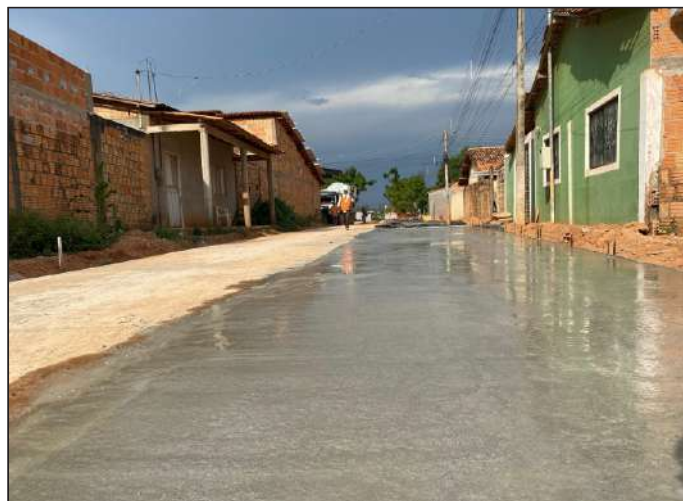
Pavimentação é realizada em concreto armado para maior resistência
