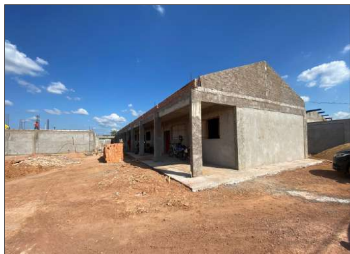
Salas já estão 90% rebocadas
