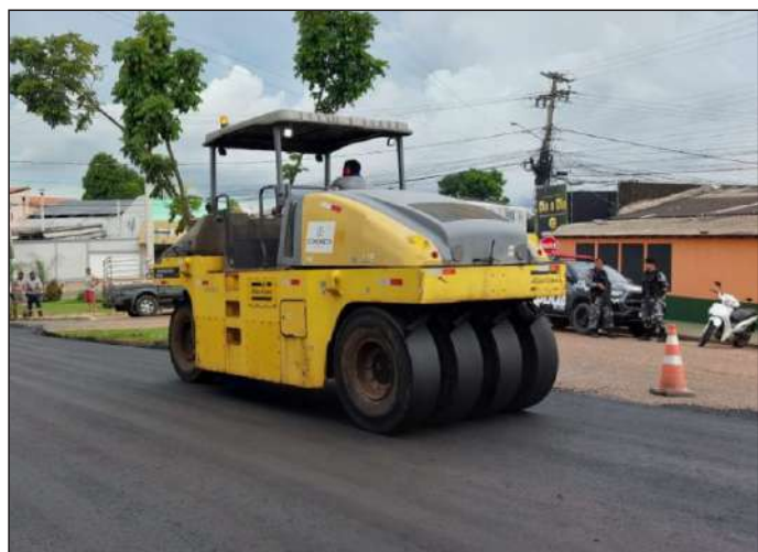
Serviço conta com auxílio de máquinas da Secretaria de Viação e Obras Públicas (Sevop)
