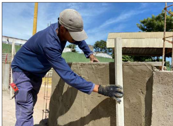
Estrutura da arquibancada terá dimensão de 31x13 metros
