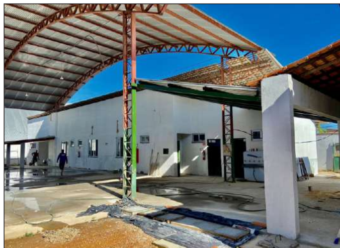
Cobertura e pintura externa estão em fase de finalização
