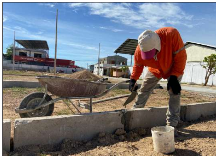
Começaram as instalações das primeiras estruturas
