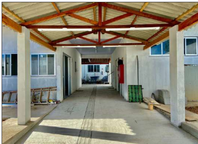
Toda a área administrativa e banheiros ganharam reforma
